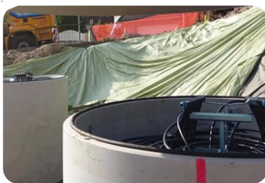
©Fernwärme Weiz GmbH
